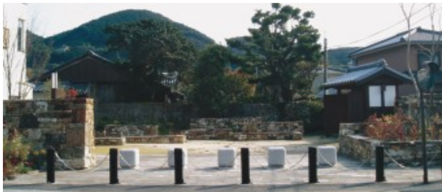
広場に奥行きが感じられるとともに隣地の石塀、庭木、住宅と一体となった風景となるよう、高さの異なる石塀を配置
