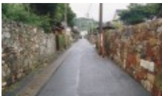
武家門と石塀を復旧し、武家屋敷通りの街なみの連続性を確保
